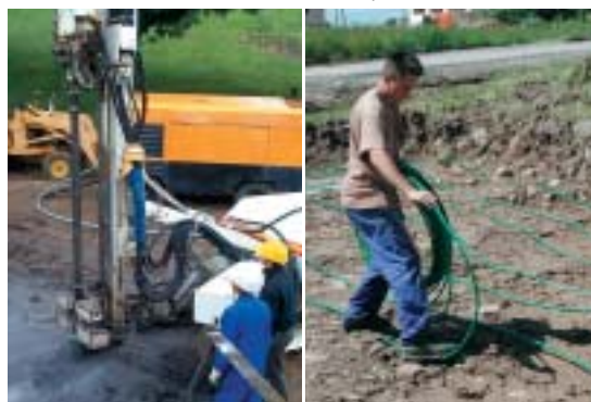
Pose d'une sonde géothermique (à gauche) et de capteurs horizontaux (à droite).
